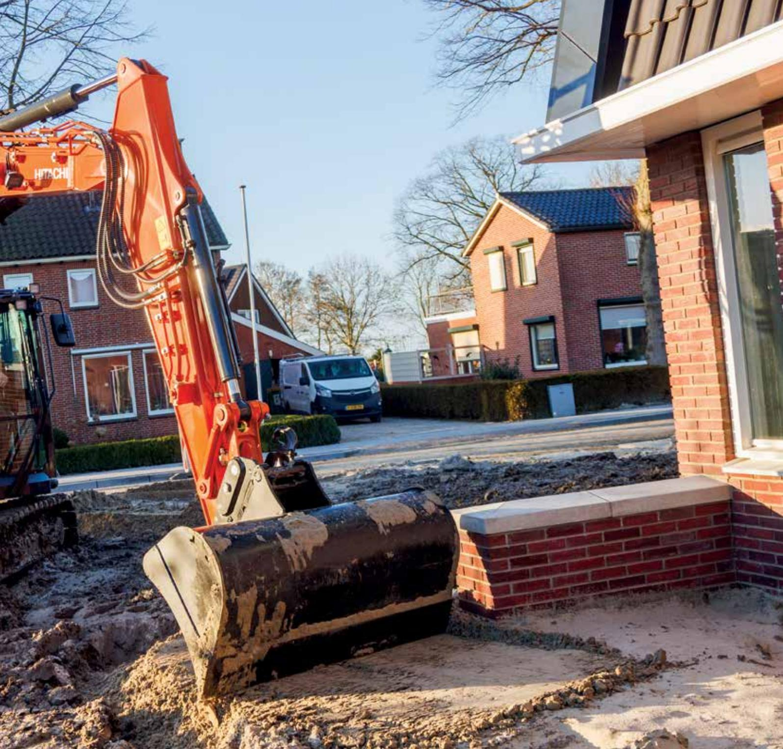
Kurzer Abstand zwischen Löffel und Planierschild sorgt für mehr Effizienz und Sicherheit.
